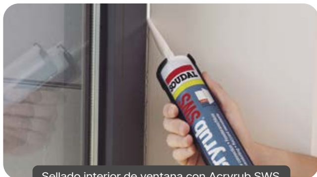
Sellado interior de ventana con Acryrub SWS
