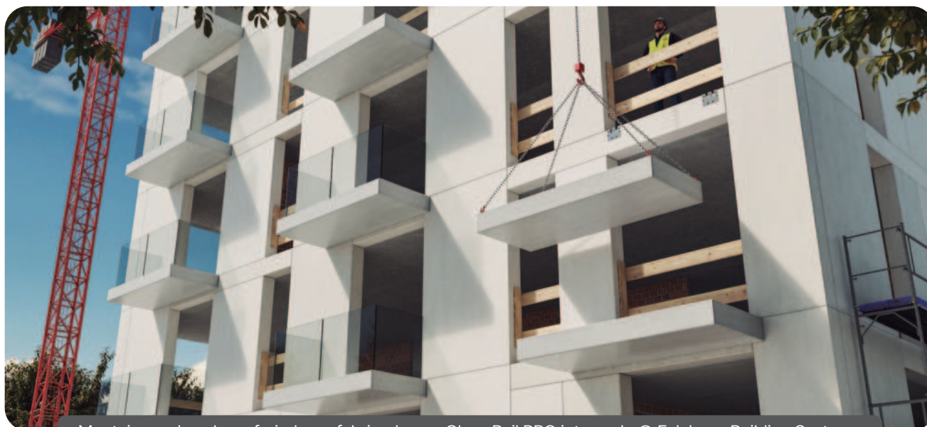
Montaje en obra de un forjado prefabricado con Glass Rail PRO integrado © Exlabesa Building Systems
